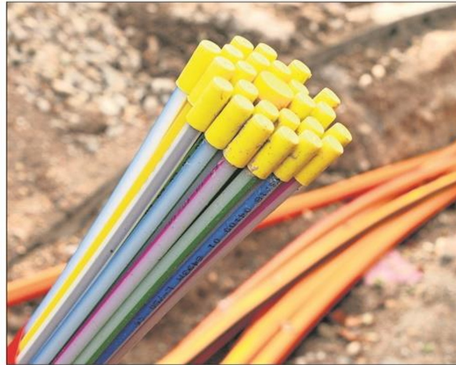
Für ein schnelles Internet wird in Bühl eifrig gearbeitet. Dieses Foto ist im vergangenen Herbst in Weitenung entstanden, als weitere Versorgungskabel verlegt wurden. Foto: Kachel
